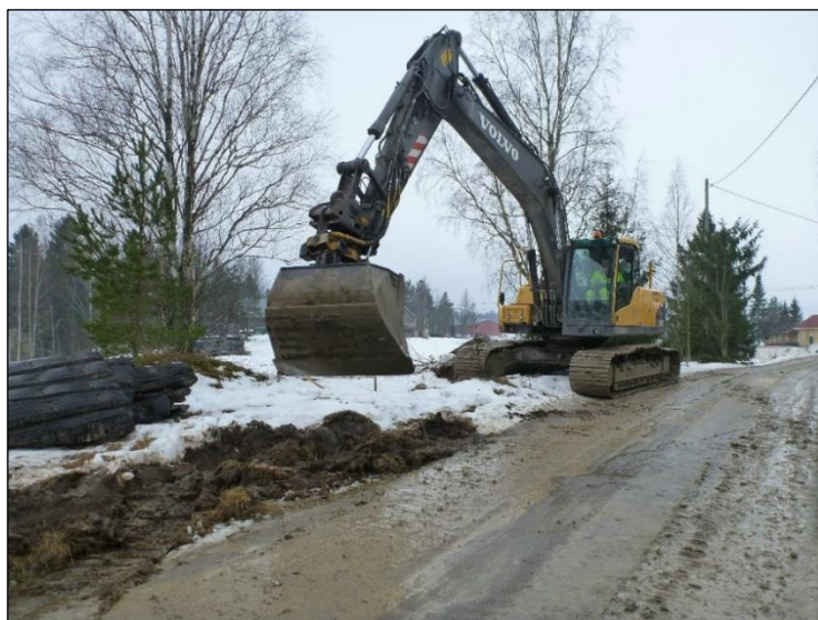
Tutkimusalueen koillisosa ennen kaivutöiden aloittamista. Lounaaseen.
