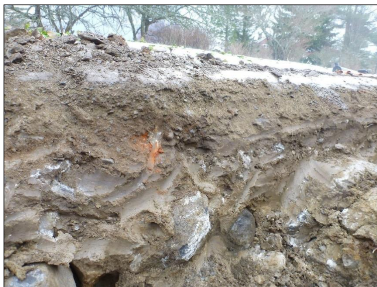
Tiilen pala Karjamaantien pinnassa, ammuttujen kivien päälle olevassa tasauskerroksessa. Pohjoiseen.
